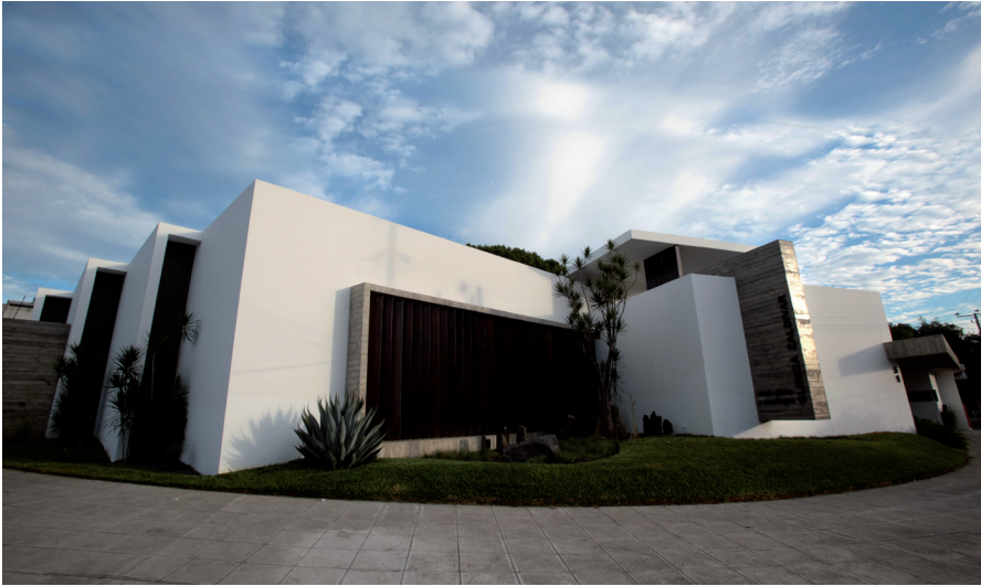
Vista exterior, Clínica Zaldivar, San Salvador (Alvarez, 2010) Fotografía de Óscar Leiva (2012), propiedad de Fundación AccesArte
